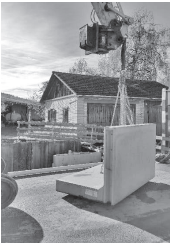
Einbau Fertigbetonelemente
