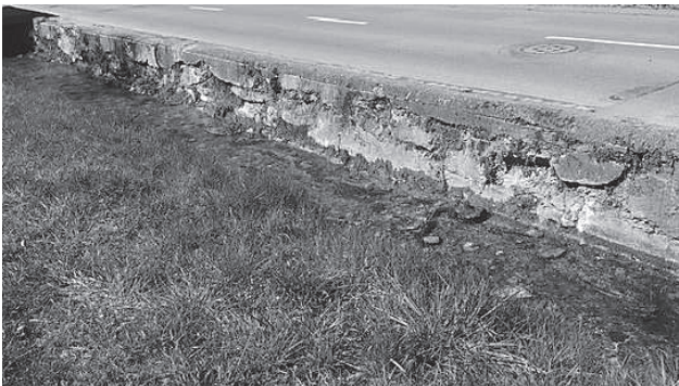
Bachmauer vor der Sanierung
