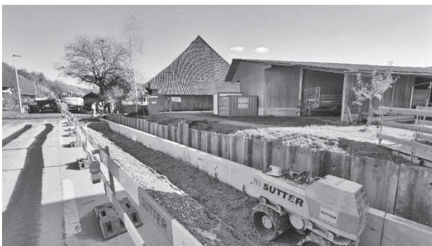
Hinterfüllung Bachmauer
