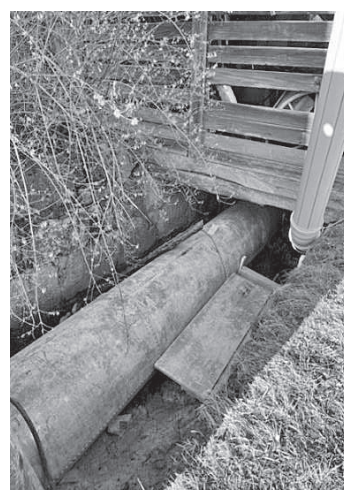
Wasserhaltung für Sanierung Widerlager
