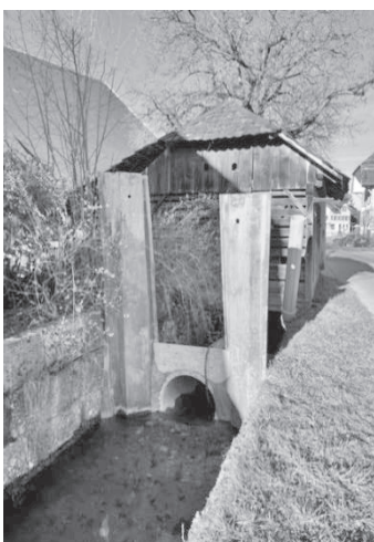
Wasserhaltung für Sanierung Widerlager
