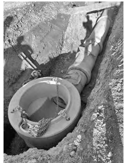
Schacht Abwasserleitung
