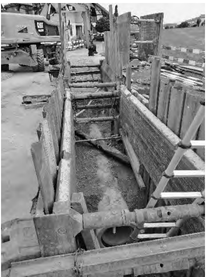
Einbau Abwasserleitung
