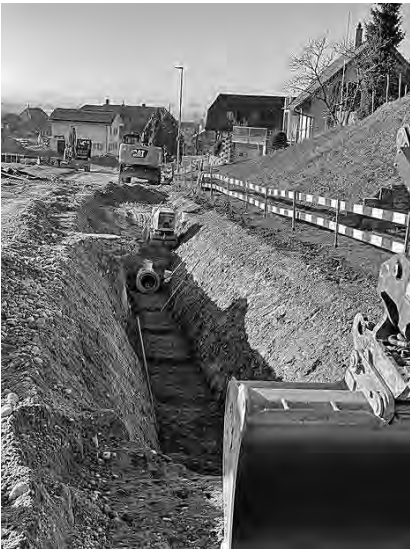
Einbau Abwasserleitung
